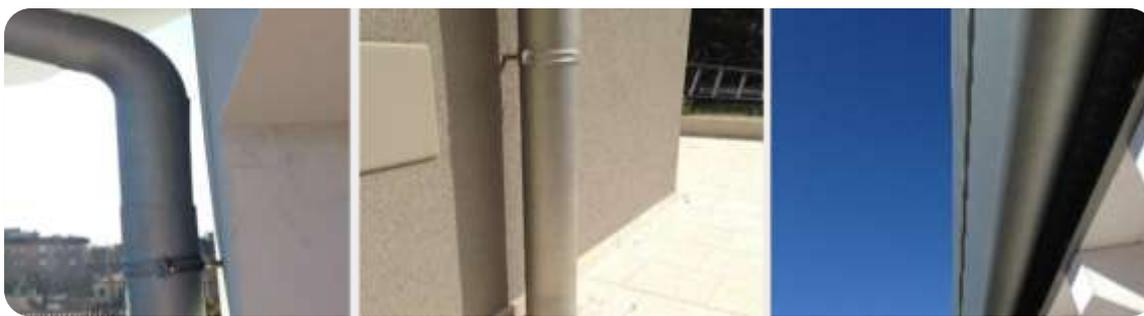
I vantaggi dell'alluminio rispetto al rame sono la leggerezza, la facilità di lavorazione, la capacità di mantenere il colore (vernici) inalterato per molto tempo.
